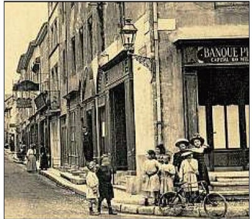
Comme les autres réverbères à l'huile de la commune, celui situé à l'angle de la rue d'Italie et de la rue Joseph-Savoyat, a été remplacé par l'éclairage au gaz.
