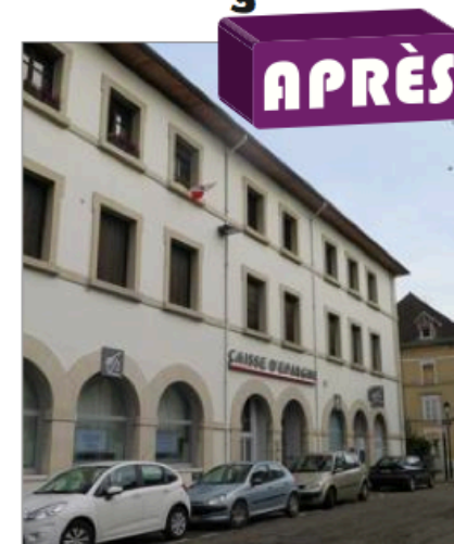
En 1977, la nouvelle Caisse d'épargne avec ses arcades en façade et son toit dauphinois recouvert de tuiles écailles vieilles,
