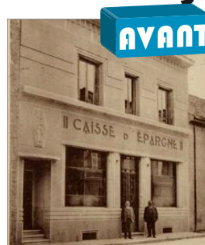
Ce bâtiment inauguré le 3 septembre 1933 a été une importante étape par rapport à la salle des mariages de l'ancienne mairie.
