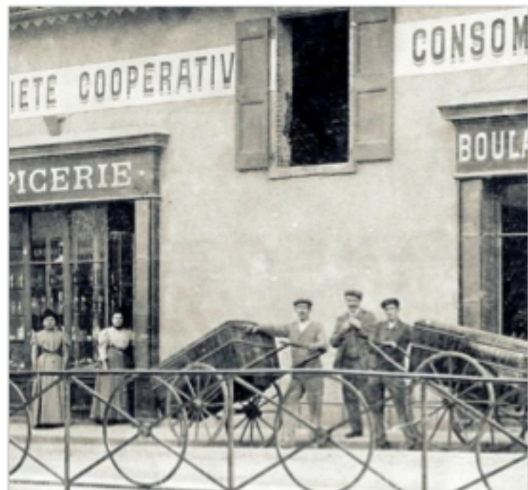
Au début du XX e siècle, au 5 rue des Récollets, la Coop livrait épicerie et pain chez les Turripinois, avec des charrettes à bras.
