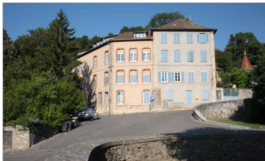
Bâtiments réhabilités pour en faire un immeuble d'appartements privés.
