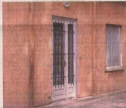
Dans la cour arrière de l'usine, on peut encore voir les poteaux caractéristiques des anciens ateliers de soierie. C'est ici que toute la soie était transformée en tissu.
