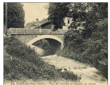
LA TOUR-DU-PIN (Isère) - Pont de Prailles et Chemin du Stand
